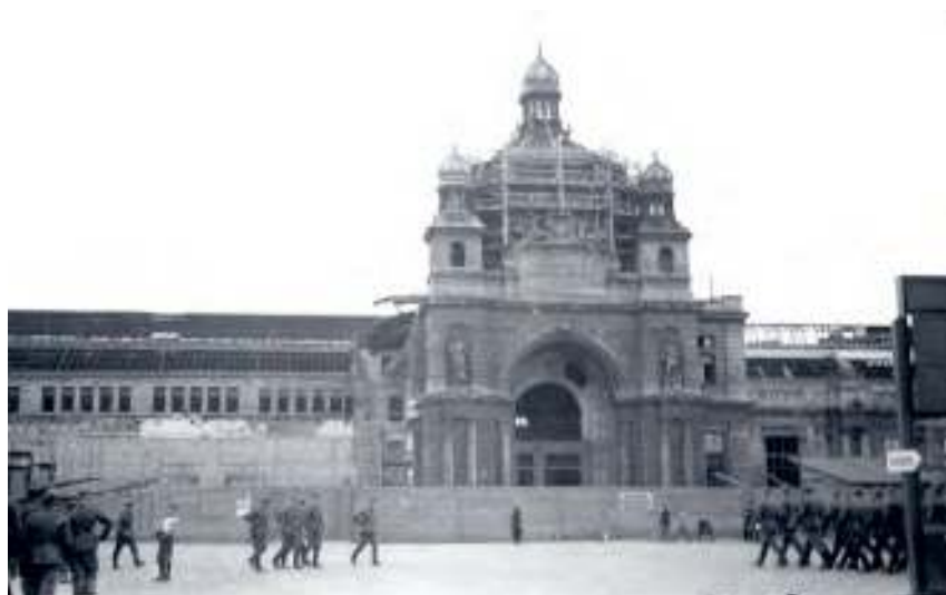
Der Hauptbahnhof von Lemberg 1941, während der Reparatur von Kriegsschäden, an der Józef beteiligt war.
